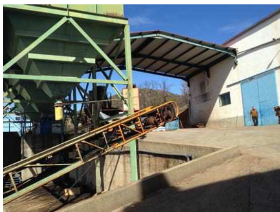
Instalaciones de la cooperativa.
